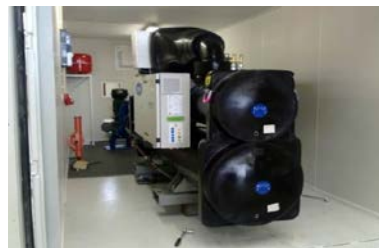
30XWP watergekoelde chiller in de container bij Refresco
